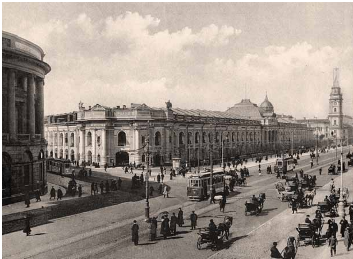
Большой Гостиный Двор в Петербурге, начало XX в.
